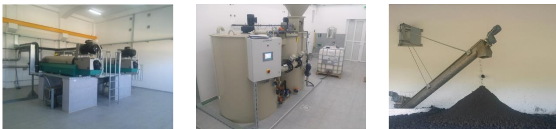
Слика бр. 10. Центрифуге, полимерна станица и дехидрирани муљ
